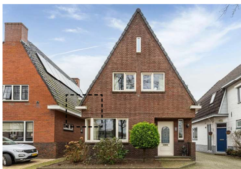
Zadeldak lage gootlijn zonder overstek (en windveer)
