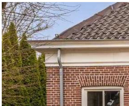
Bakgoot met klassieke profilering, direct op het metsewerk geplaatst zonder overstek (dak blijft binnen de gevellijn)
